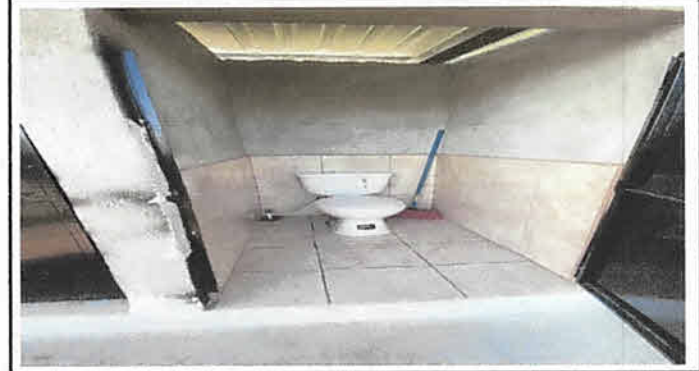
Foto 4: SANITARIOS E INSTALACION DE PISO CERAMICO
