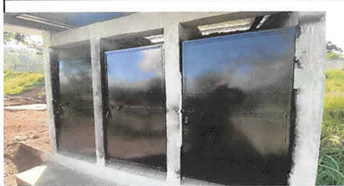
Foto 3: SUSTITUCION Y ELABORACION DE PUERTAS SANITARIOS
