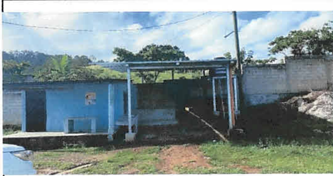
Foto 1: AREA DE PILA TECHADO E INSTALACION DE TINACO Y ESTRUCTURA PORTANTE
