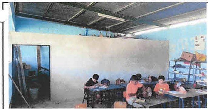
Foto 5: PARED EN AULA PARA USO DE BODEGA CON PUERTA
