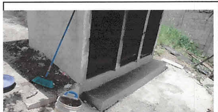
Foto 6: ACCESO A SANITARIOS
